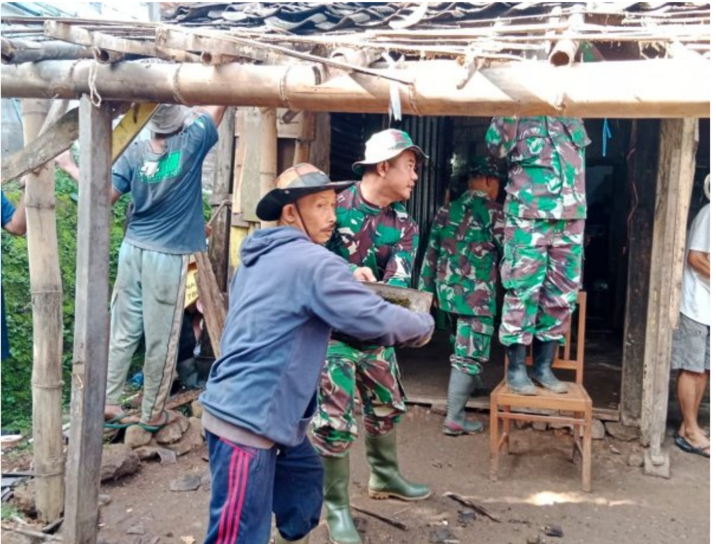
Pembongkar Rumah Sasaran RTLH
