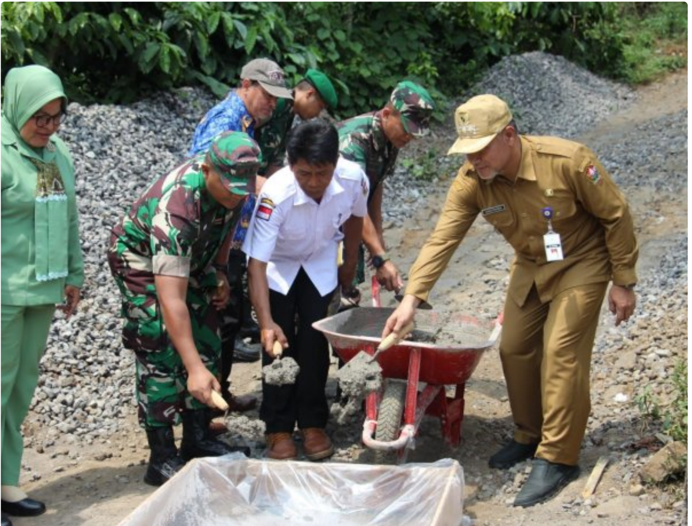
Simbolis Pengecoran Pertama Betonisasi
