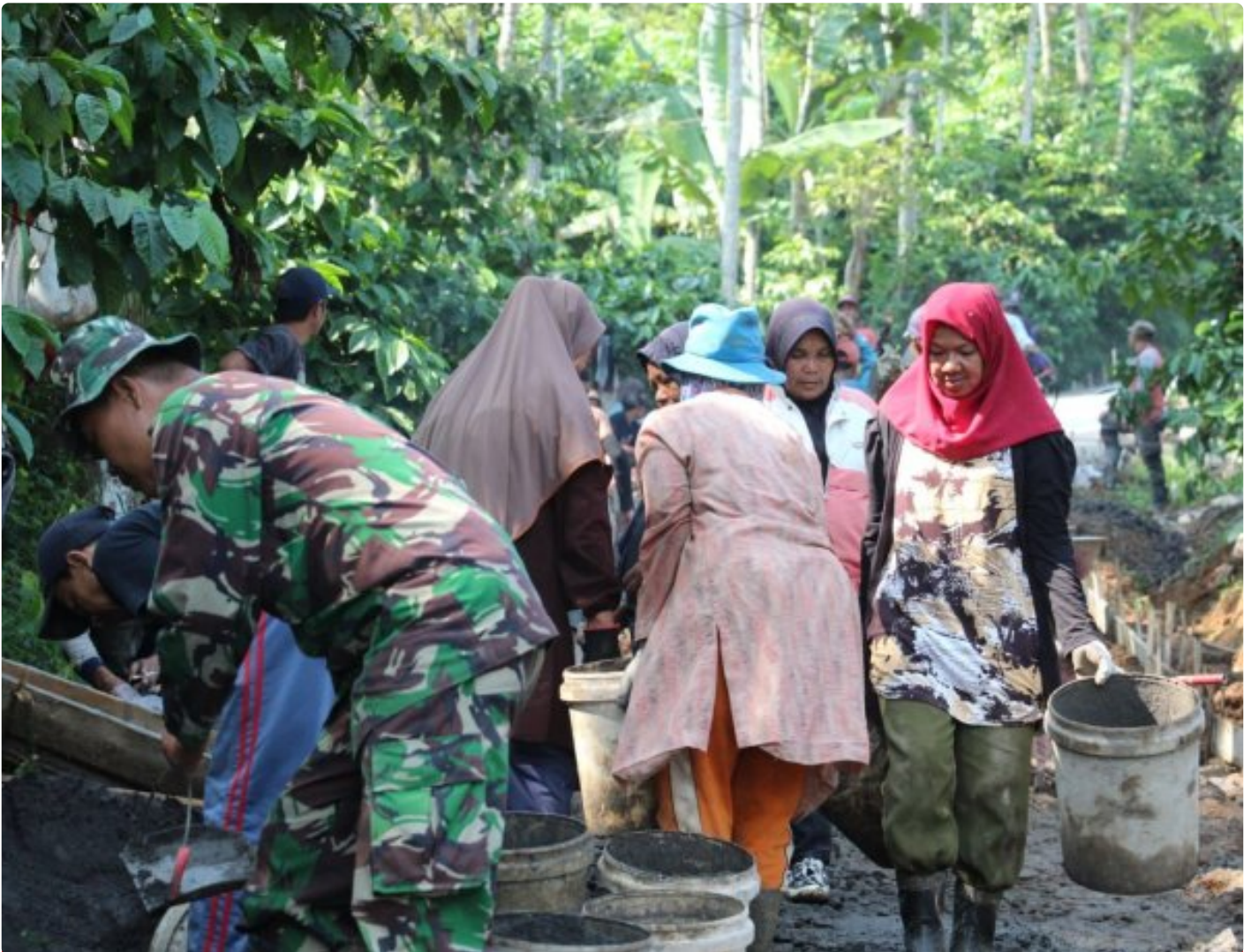
Ibu Ibu Bantu Percepat Pembangunan TMMD
