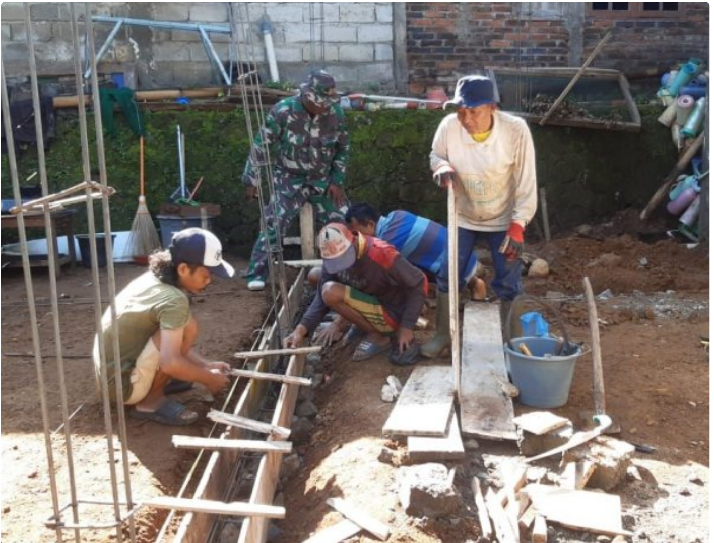
Pemasangan Bekisting Balok Sloof
