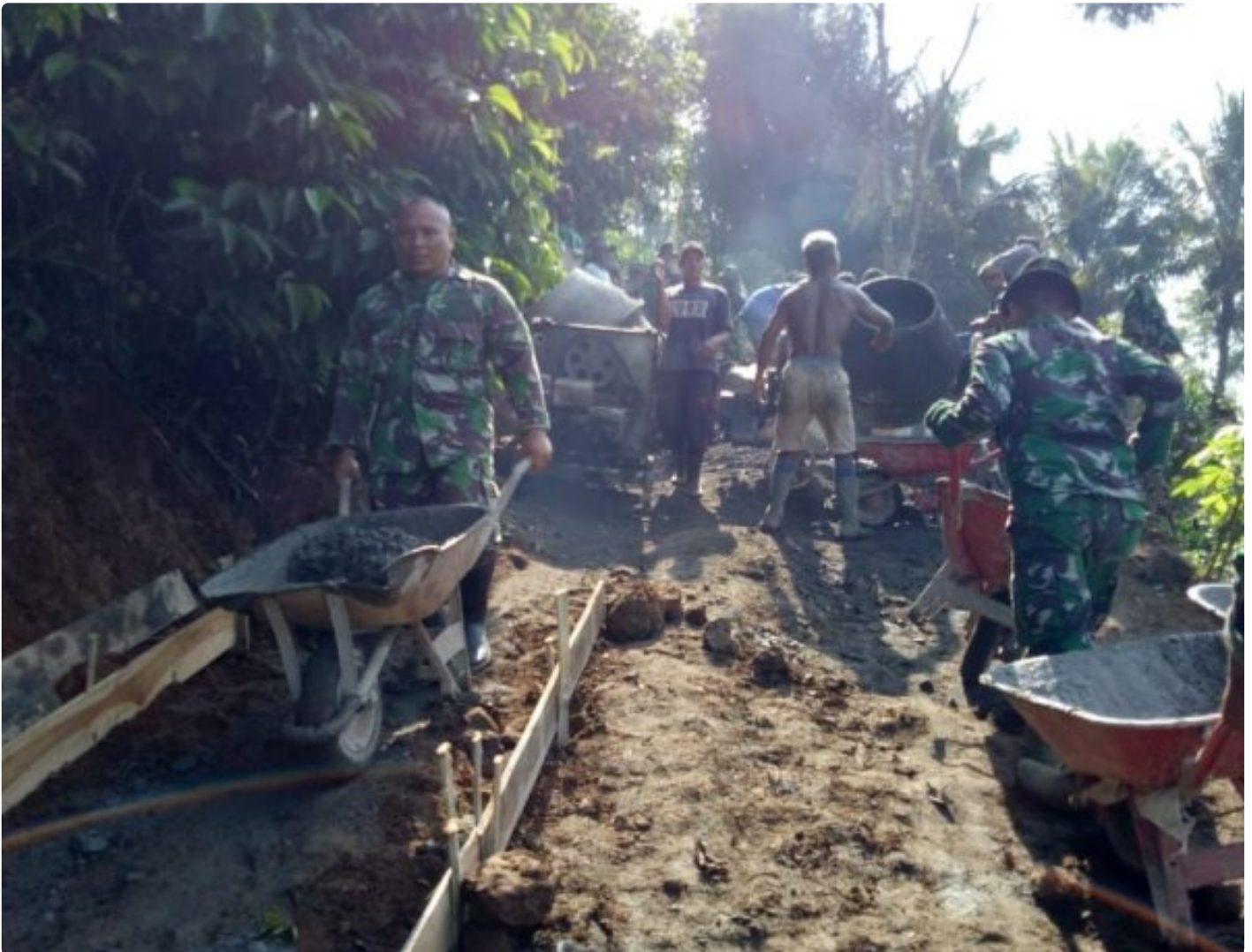
Satgas TMMD Kebut Pengecoran Jalan
